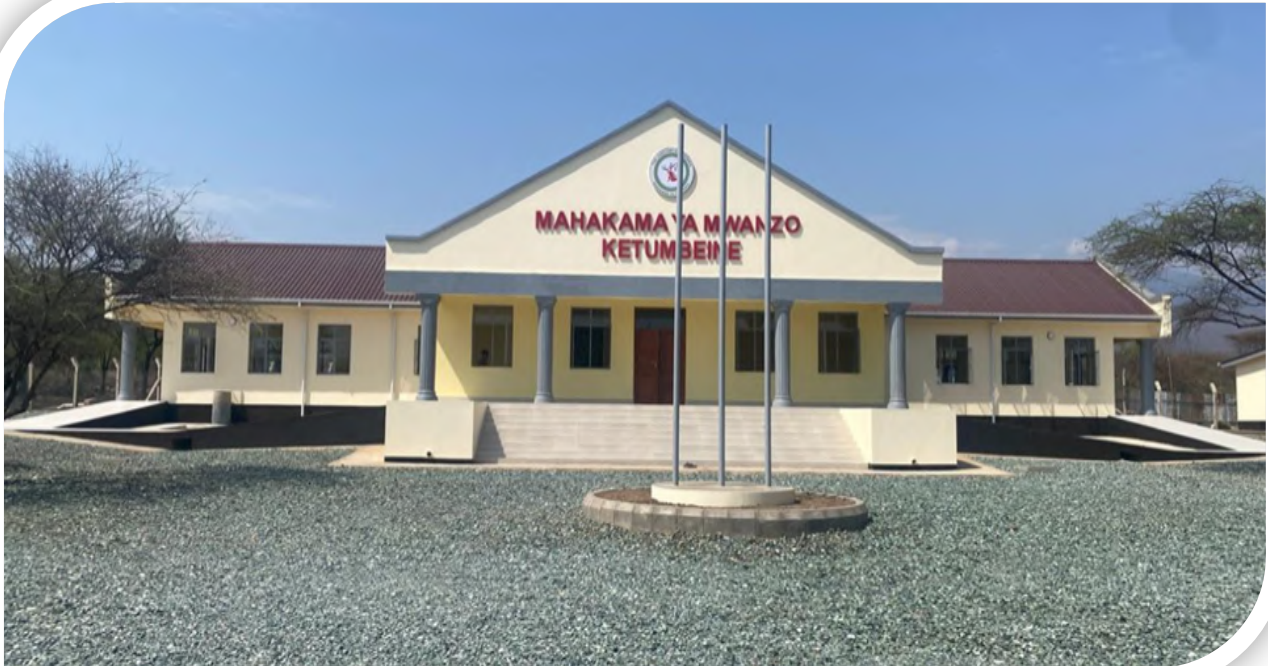
Jengo la Mahakama ya Mwanzo Ketumbeine Wilayani Longido Mkoani Arusha katika muonekano wa sasa tarehe 26 Machi, 2026, jengo hili limekamilika kwa 100%
