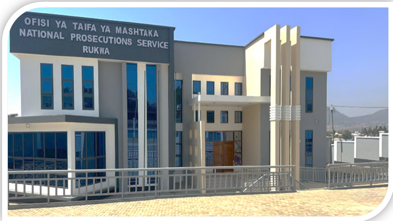
Jengo jipya la Ofisi ya Taifa ya Mashtaka Mkoa wa Rukwa, linalowakilisha majengo yote ya Ofisi ya Taifa ya Mashtaka yanayojengwa na yaliyokamilika
